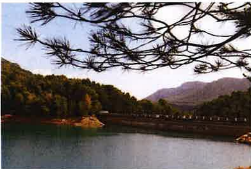
Barrage du Revest les Eaux (Var)
